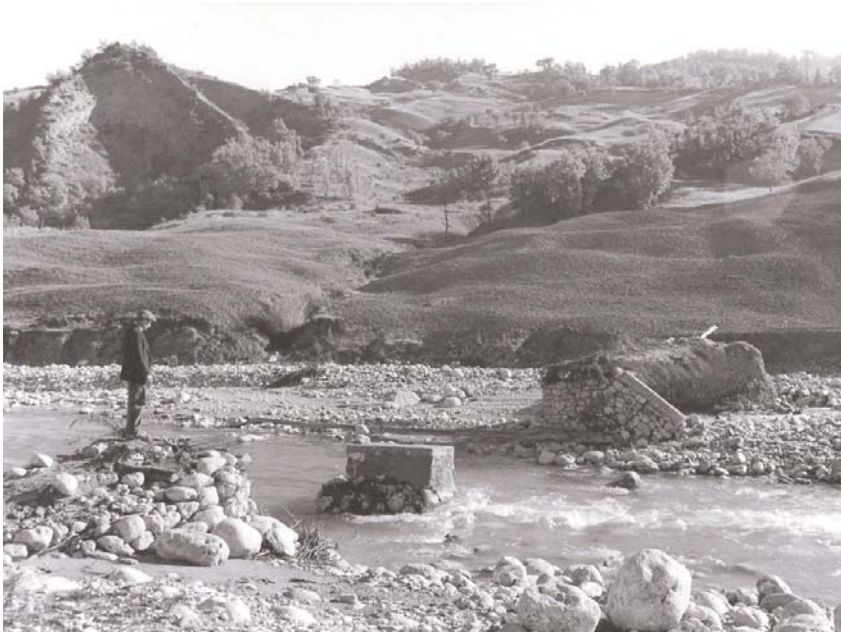
Carceri Alte (frazione di Ateleta): le rovine del ponte distrutto dai bombardamenti (foto di Florita Botts).
